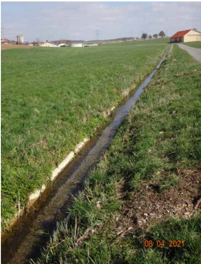
Typisches Bild eines ausgebauten Baches in Hohenlohe (Feßbach): Keinerlei Bepflanzung, Sohle mit Betonschalen ausgelegt
