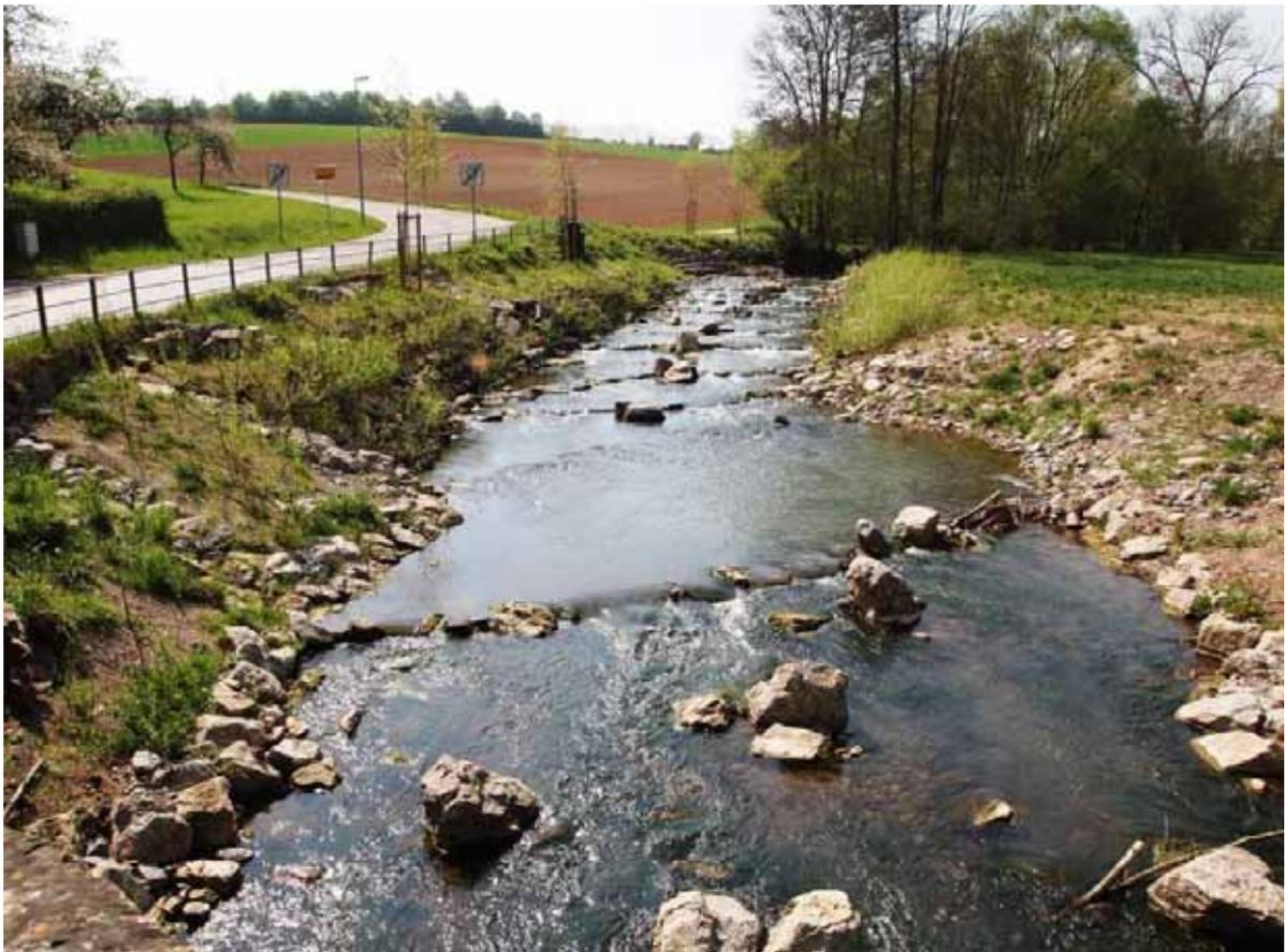
**Abb. 57:** Die Befischungsstrecke M7 in der Metter am Ortsanfang von Metterzimmern. Die Weiden in den Faschinen der Uferbefestigung haben gerade erst ausgeschlagen, so dass hier wesentliche Strukturelemente noch nicht ausgebildet sind. Die günstige Strukturbewertung bezieht sich deshalb auf den endgültigen Zustand.
