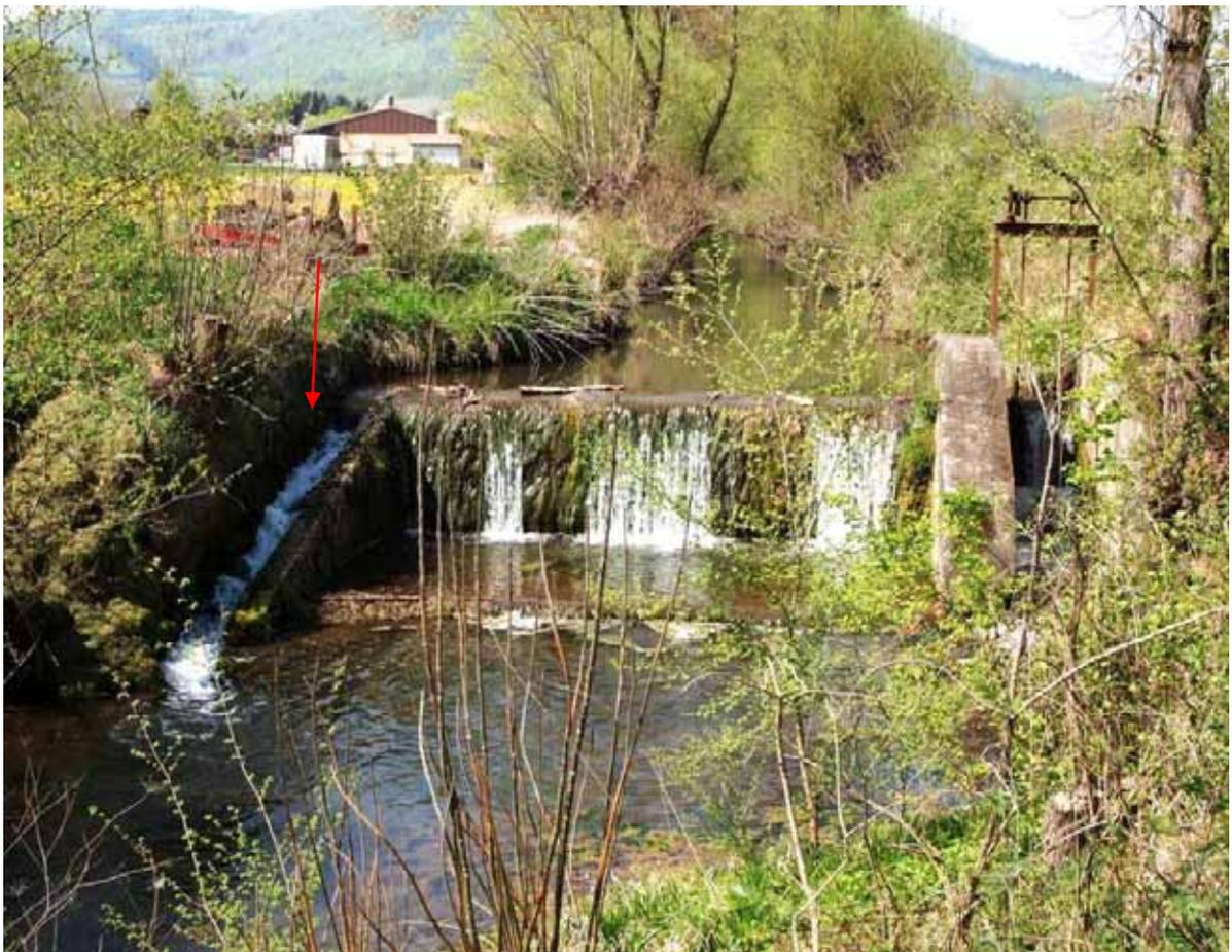
**Abb. 102:** Die Wehranlage im Kirbach, ca. 200 m unterhalb der Befischungsstrecke K1 (s. Abb. 73), mit der nicht funktionsfähigen Fischtreppe (s. Pfeil).
