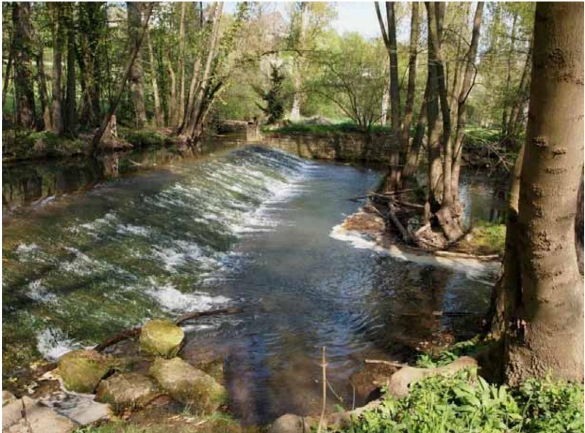
**Abb. 63:** Die Befischungsstrecke M9 in der Metter am Beginn unterhalb des Schrägwehres. Das Schrägwehr ist aufgrund der hohen Fließgeschwindigkeiten von über 1 m/s für den Strömer und auch für andere Kleinfische nicht überwindbar.
