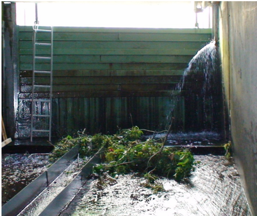
Abb. 10. Eine mit Geäst verlegte Abstiegsrinne verhindert die schadlose Rückführung von Fischen in das Unterwasser.
