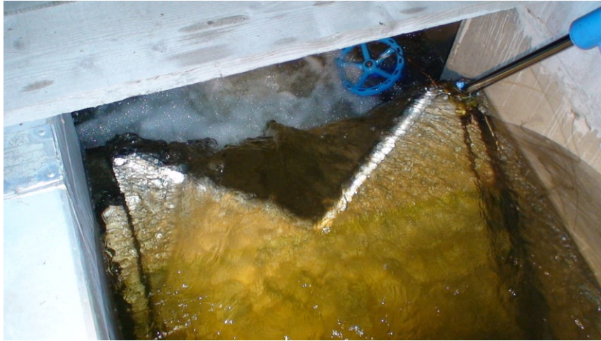
Abb. 9. Starke und abrupte Zunahme der Fließgeschwindigkeit in der v-förmigen Kerbe (Bündelung des Wasserstrahls, die Fließgeschwindigkeit nimmt auf einer Strecke von ca. 0,8 m um über 1,5 m/s zu).
