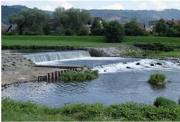
Abb. 9. Kinzigwehr in Gengenbach vor dem Bau einer Wasserkraftanlage
