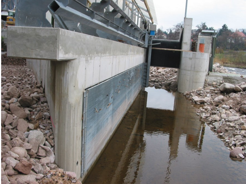
Abb. 5. Anlage „Klingelmühle“ in der Bauphase, Blickrichtung gewässerabwärts: schräg angeordneter Horizontalrechen mit Bypassöffnung im spitzen Winkel.
