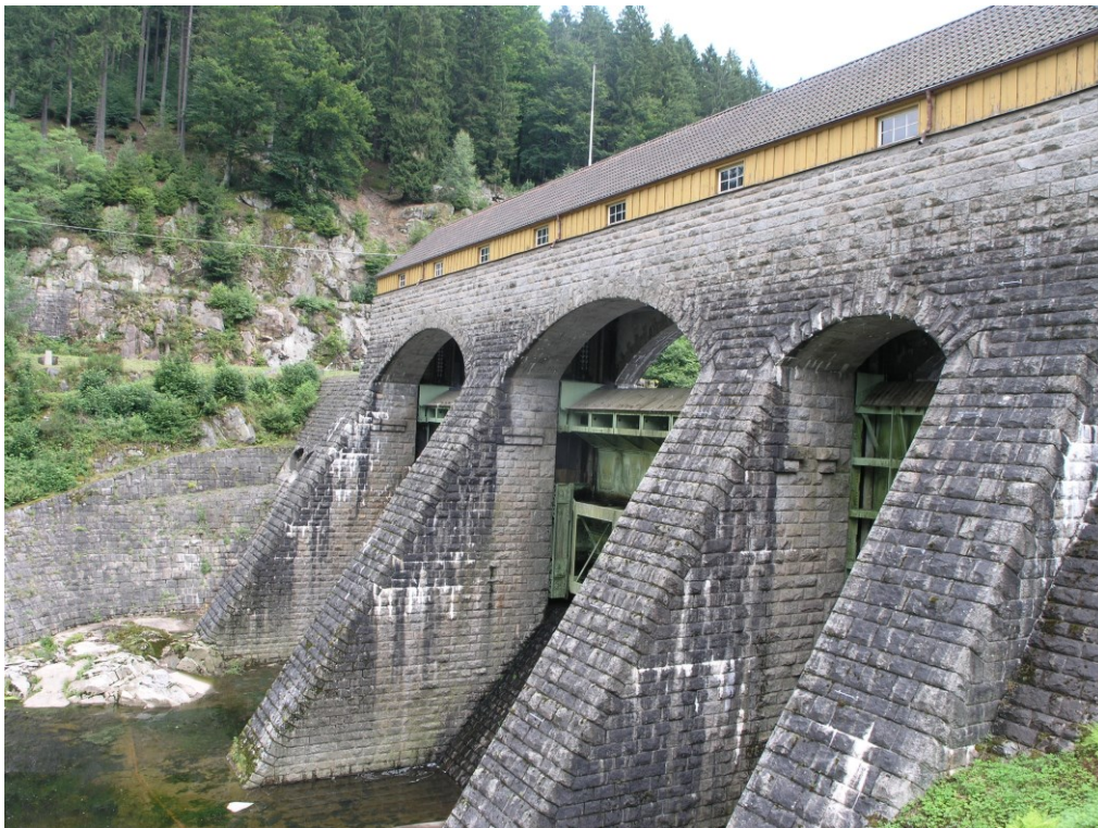
Ausgangssituation fischökologischer Optimierung an Fließgewässern: Unterbrechung der Durchgängigkeit und Aufstau in Fließgewässern durch Querbarrieren zur Wasserkraftnutzung
