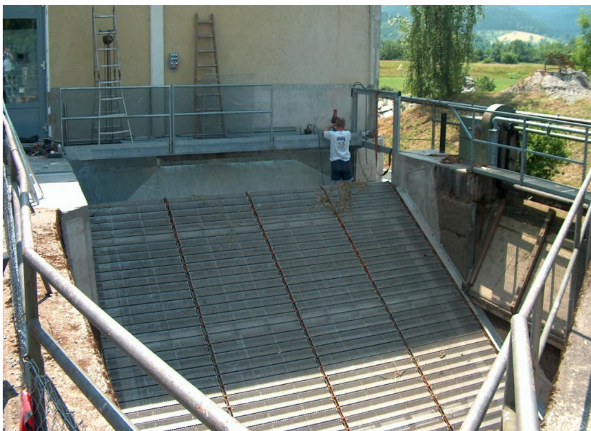
Abb. 6. Anlage „Steinach CR“ in der Bauphase: rechtwinkelig zur Fließrichtung angeordneter Lochblechrechen mit flacher Neigung, seitliche Bypassöffnung noch nicht installiert.
