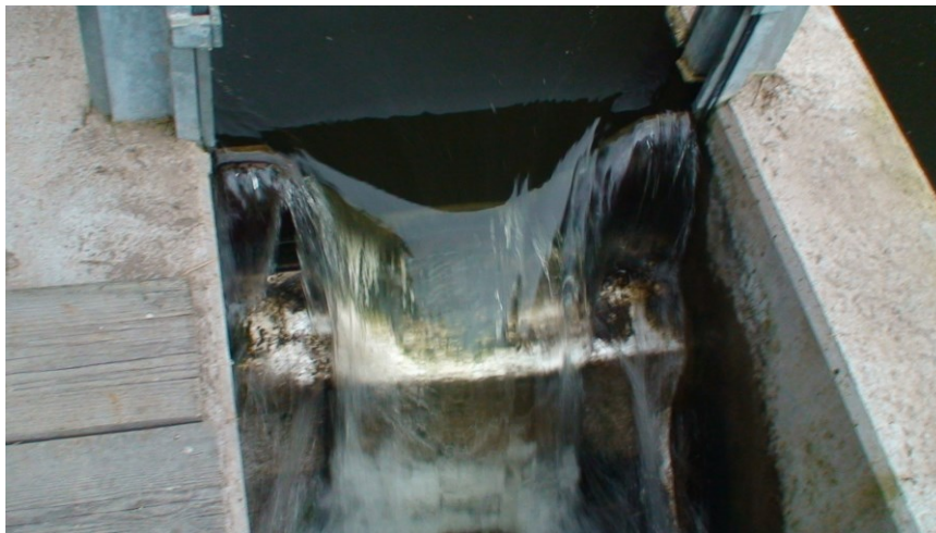
Abb. 8. Ablöster Überfallstrahl am Bypasseinstieg
