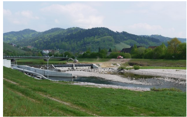
Abb. 10. Kinzigwehr in Gengenbach mit Wasserkraftwerk
