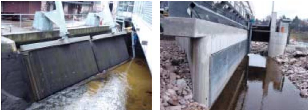
Als Abstieghemmnisse konnten abgelöste Überfallstrahlen und Wasserwalzen, die eine regelmäßige Umkehr oder Zerschlagung der Strömung vor dem Bypasseinstieg bewirkten, detektiert werden. Weiterhin wurde auch an Bypassabschnitten, die eine sehr starke Fließgeschwindigkeitszunahme auf kurzer Strecke aufwiesen (Befund auch beschrieben bei HARO et al 1997) oder bei zu niedrigem Wasserpolster über einem Zwangspunkt (z. B. Rechenoberkante) eine geringere Frequenz an Abstiegen registriert.
