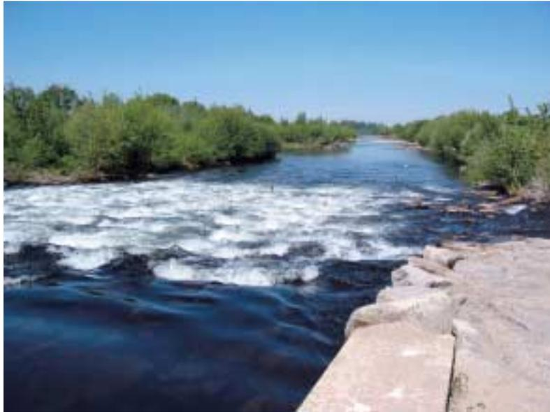
Umbau des „Neumühler Wehrs“ in eine Raue Blocksteinrampe
