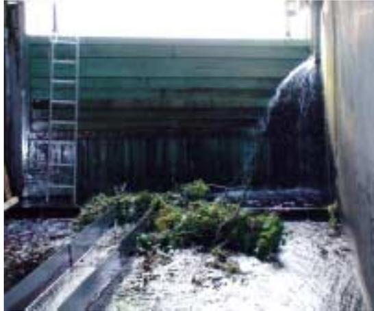
Laut Auskunft der Wasserkraftanlagen-Betreiber ist die Betriebssicherheit von 10 mm-Rechen gewährleistet und betriebswirtschaftlich vertretbar. Beispiel: Turbine hinter „CR“ lief bei hohem Laubaufkommen durch, bei konventionellem 20 mm-Rechen (Anlage oberhalb) musste die Turbine abgeschaltet werden.
