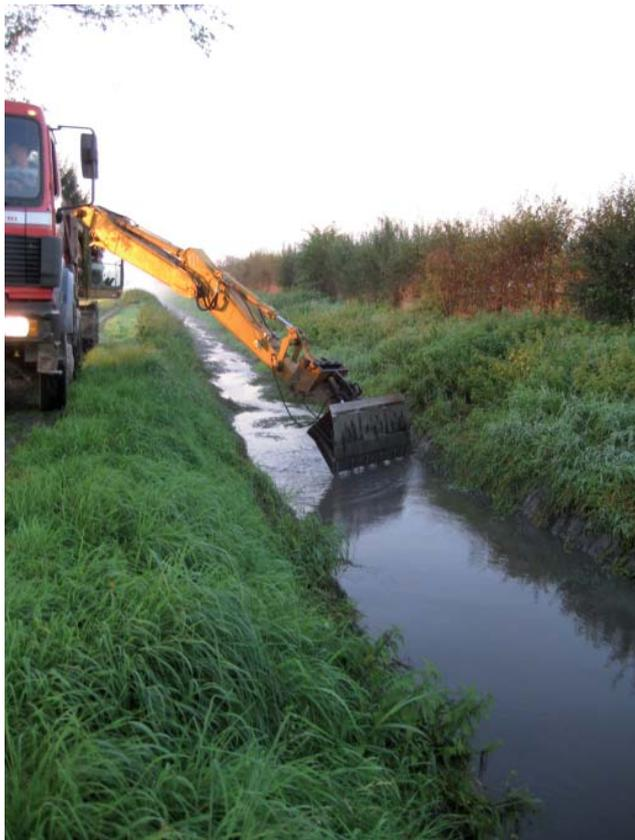
Abb. 41: Grabenräumung mittels Bagger
