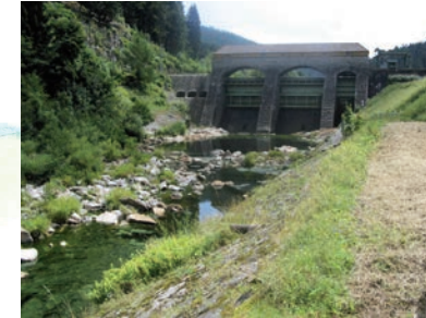
Stauwehr mit Ausleitungsstrecke (Murg)
