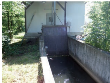
Triebwerkskanal und Rechen (Elz)
